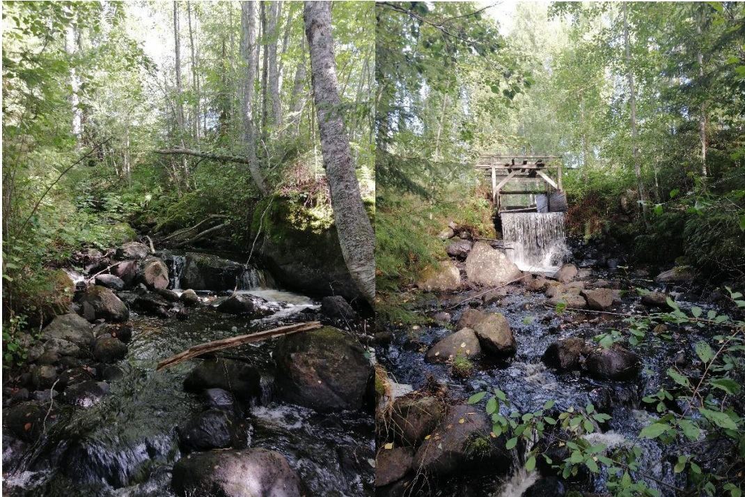
Kuva 2 ja 3. Noususte Koskelankosken padon alapuolella ja Koskelankosken pato
